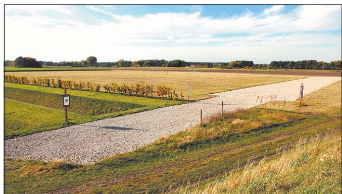
Teile der Schutzgräben (links) sowie einige Straßen, die durch das Lager führten, sind bereits rekonstruiert.
